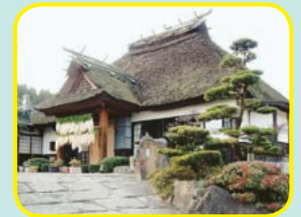
今ではめずらしくなくなったカヤぶき屋根の家
