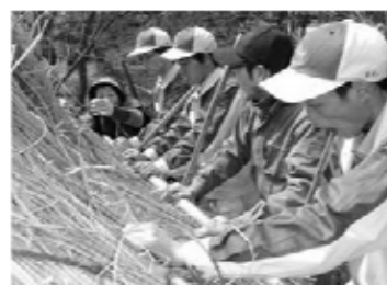
茅葺屋根の東屋製作
